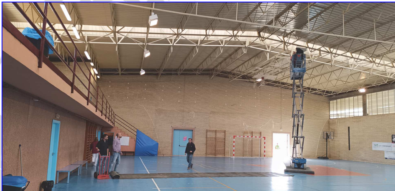
Reparaciones en las instalaciones deportivas municipales.
