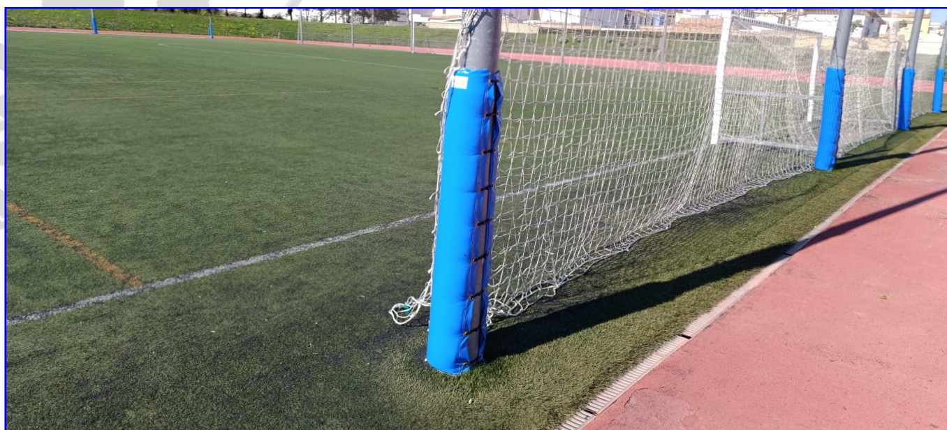
Reparaciones en instalaciones deportivas municipales.
