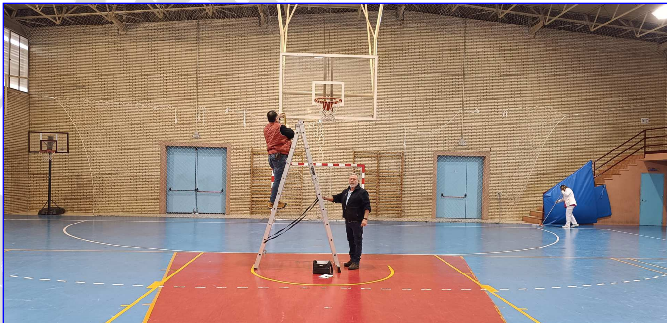
Reparaciones en las instalaciones deportivas municipales.
