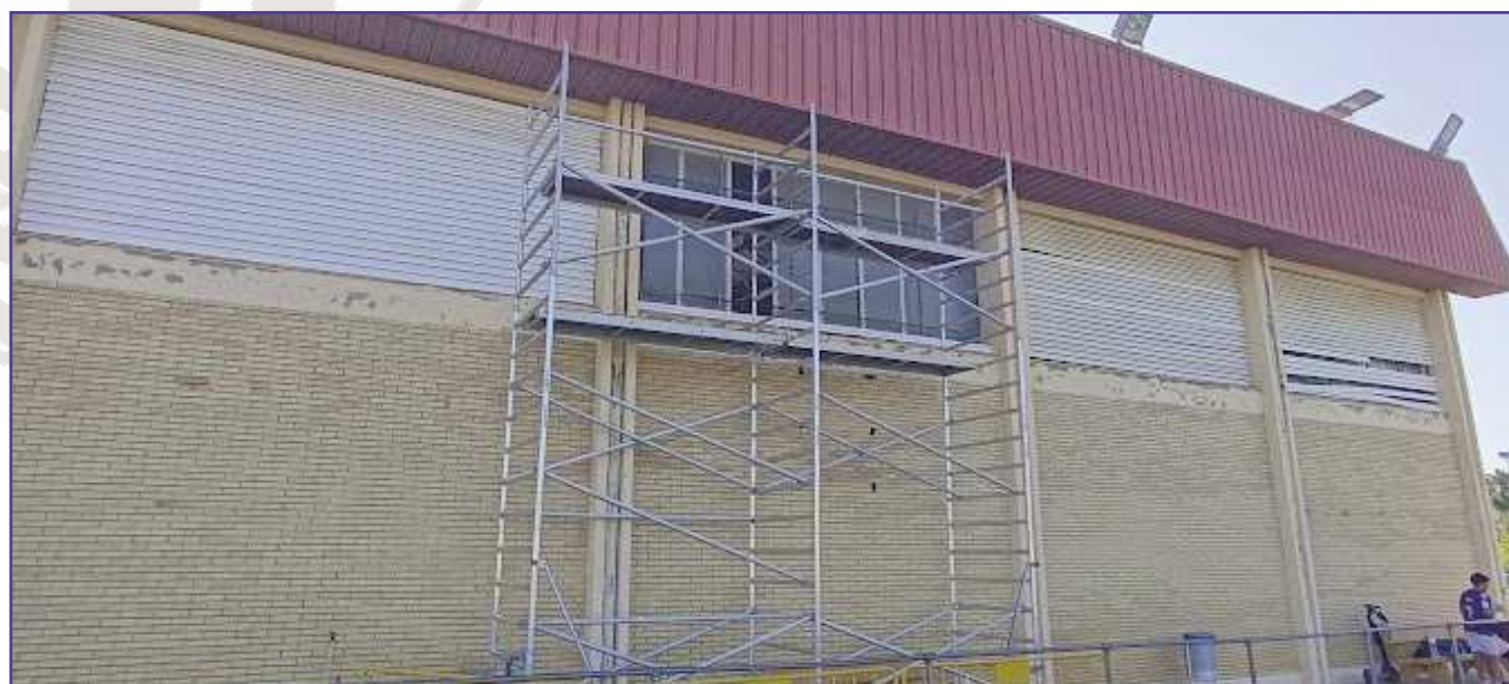
Reparaciones en las instalaciones deportivas municipales.
