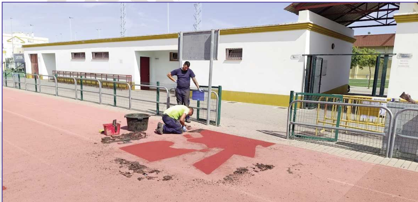
Reparaciones en las instalaciones deportivas municipales.
